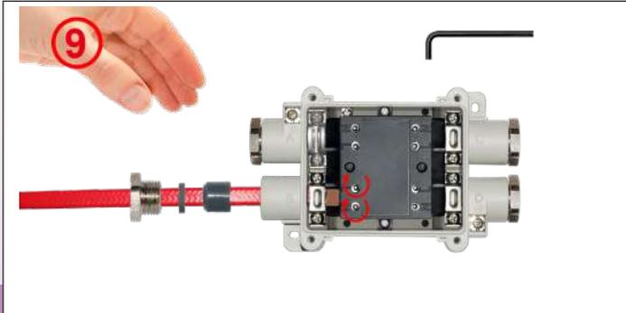
**9** : Serrer les vis des borne jusqu'à ce que le contact électrique soit effectué avec le conducteur du câble chauffant. Couple de serrage environ 1.5N.m. Ce couple de serrage peut varier selon l'épaisseur et la dureté de le matiere du mélange thermoplastique semi-conducteur. Si nécessaire verifier la continuité avec un ohmmetre en mesurant la résistance entre les deux bornes N et L.
