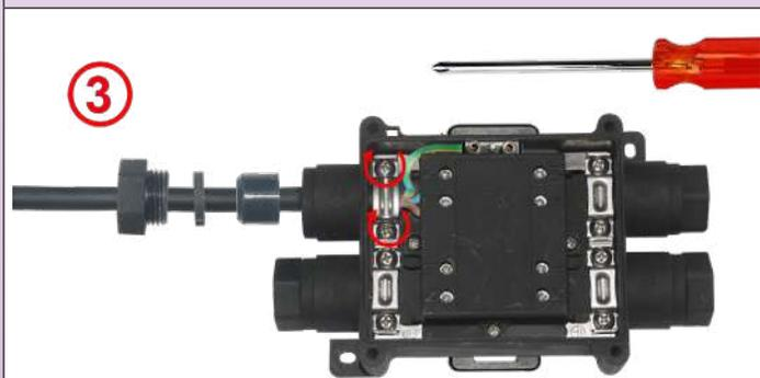
**3** : Placez l'étrier anti-arrachement et ses deux vis sur la câble, et serrez les vis. Couple de serrage recommandé 1.6N.m pour les 3 vis.
